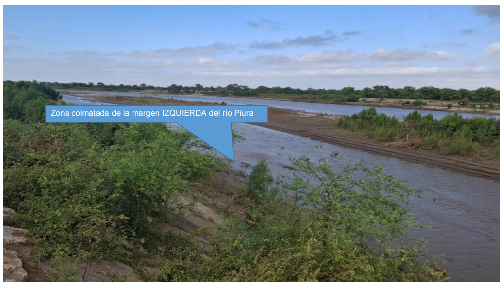
Figura N° 02: Se observa la colmatación en la margen izquierda del cauce del río Piura
